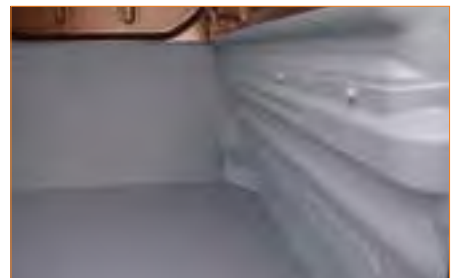
Vloer, wanden en kopschot vloeien ineens.
