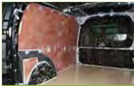
Betimmeren en voorbereiden is de basis
